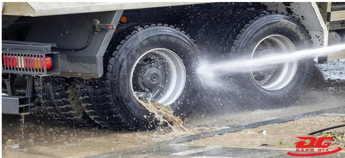
Hình 4. Hình ảnh minh họa biện pháp rửa bánh xe
